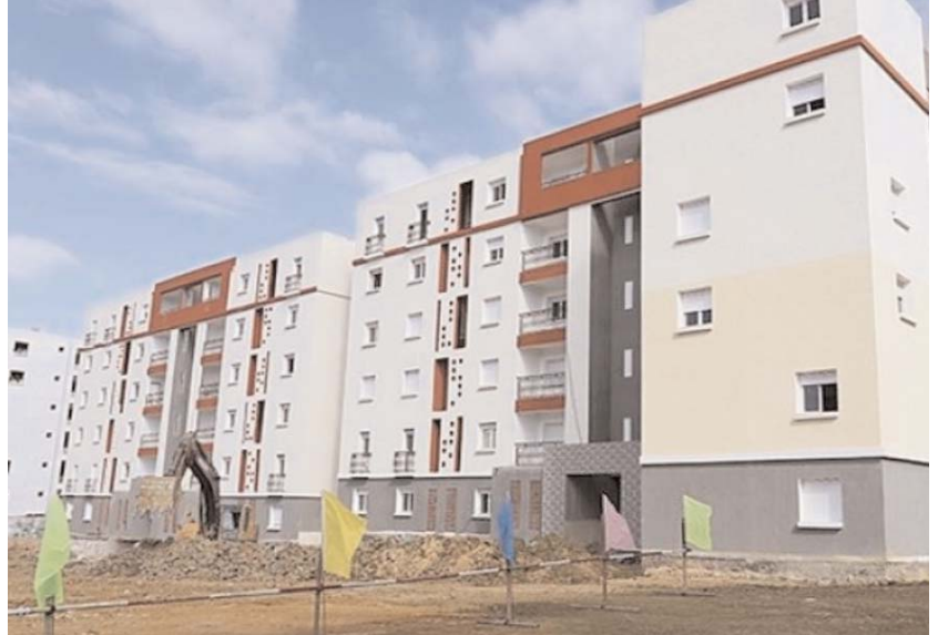
cette localité considérée parmi les plus peuplées de la wilaya. Le wali s'est, également, rendu sur les chantiers du siège de la direction régionale des douanes, et d'un bureau postal, en réalisation dans la commune, sur un total de cinq structures similaires.
