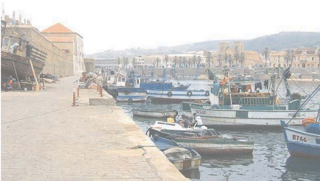
de pêche d'El Kala, réceptionné Soltani, précisant que le coût de réalisation de cette infrastructure maritime dont les travaux ont été lancés il y a plus de deux décen-
